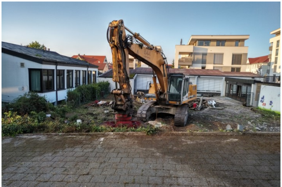
Der ehemalige Spielplatz ist plattgemacht und für den Neubau bereit
