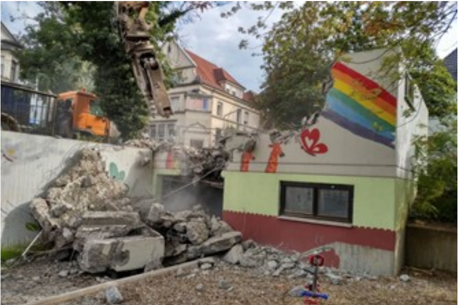
Abbruch der Doppelgarage Kaiser-/Braikestr. am 22.09.2020
